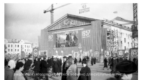
Завершення будівництва драмтеатру. Збори до роковин революції. (К. Ягодовський)
