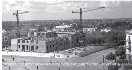
Будівництво драмтеатру. (К. Ягдовський).
